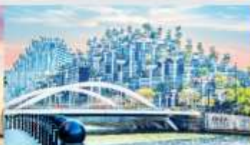
อาคารฟันทันไม้
